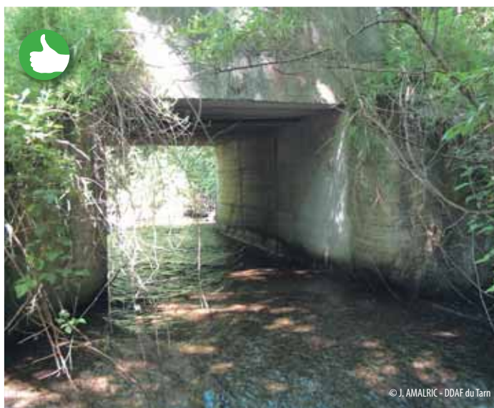
Bonne pratique - Le pont ne rétrécit pas le lit du ruisseau : peu de risques d'embâcles
