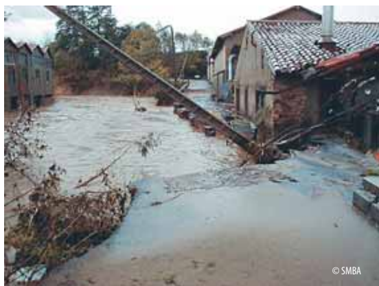
Dégâts au pont de La Richarde (nov. 1999 ; Mazamet, Tarn)
