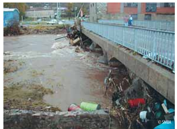
Embâcle au pont de la D 109 (nov. 1999 ; Bout-du-Pont-de-l'Arn, Tarn)
