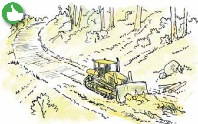
Bonne pratique - Remise en état des pistes après le chantier
